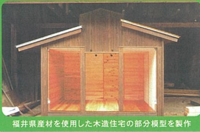
福井県産材を使用した木造住宅の部分模型を製作
